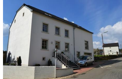
Habitation n°1 rue Huelgaass
