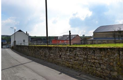
Mur en pierres sèches et jardins en hauteur
