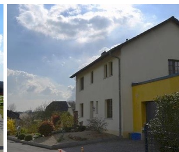
Habitation existante n°59 rue des Romains
