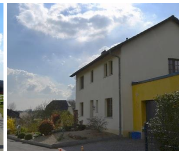
Habitation existante n°59 rue des Romains
