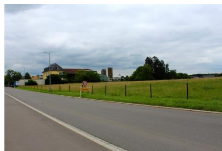
Vue du site et des constructions à l'est de celui-ci
