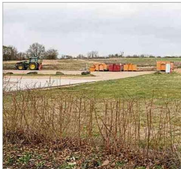
Auf dem Gelände „op Grémelter“ in Mondorf, zwischen dem Fußballstadion und der Autobahn A13 werden demnächst Bagger anrücken. Foto: Guy Jallay
