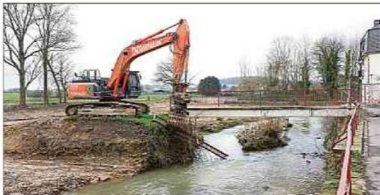
Die Arbeiten werden wohl bis zum Frühling andauern.
