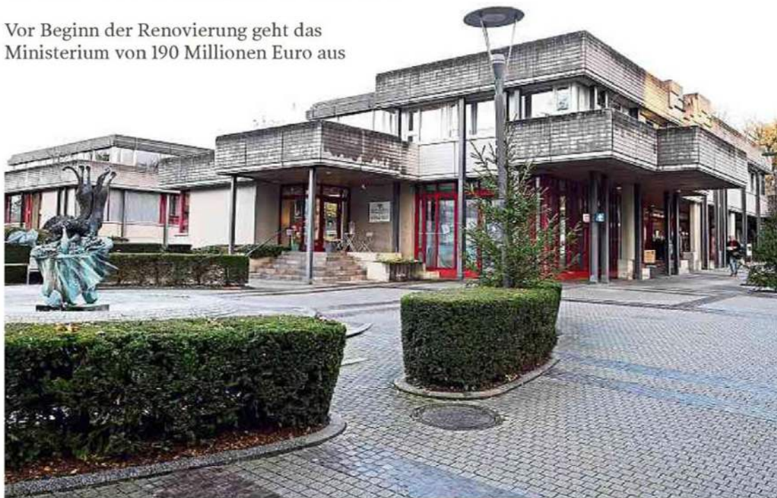
Das Gebäude ist in die Jahre gekommen.
