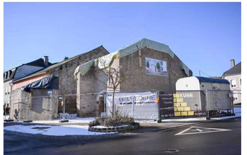
Die Scheune „A Kréiesch“ in Ellingen ist im Gemeindebesitz und soll zu einer Brasserie im Erdgeschoss und zwei Sozialwohnungen im Stockwerk darüber umgebaut werden
