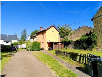
Maisons unifamiliales en cœur d'îlot, au nord du site
