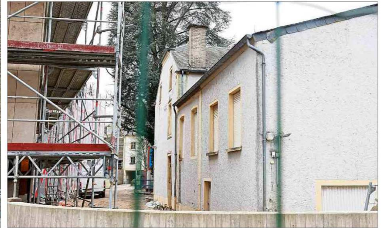
Der Anbau rechts soll später abgerissen werden. Fotos: Anouk Antony
